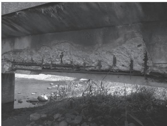
*Рис. 5.2. Пример солевой коррозии железобетонной конструкции*
