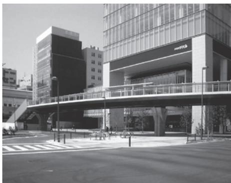
*Рис. 6.1. Пример пешеходного моста, построенного с использованием сверхпрочного бетона (фото предоставлено строительной корпорацией Кадзима)*
